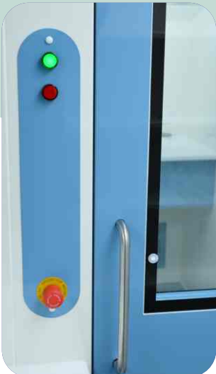
INTER-LOCK KAPI KİLİT SİSTEMİ ACİL AÇMA BUTONU
