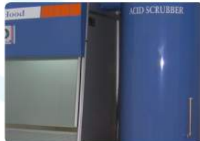
Hava içerisinde bulunan, suda çözünebilir asitleri yüksek verimlilikle tutan asit scrubber sistemi
